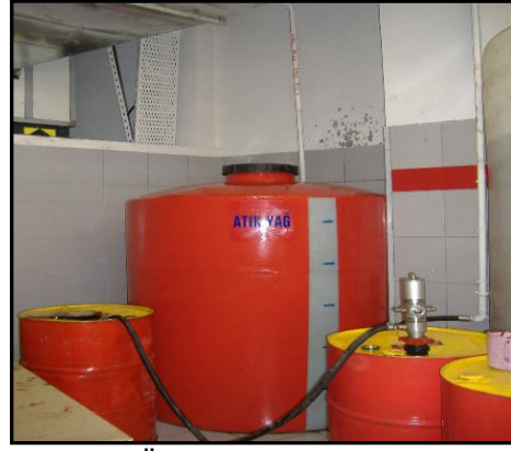
Resim 5.4: Örnek sabit bağlantılı depolama tankı
